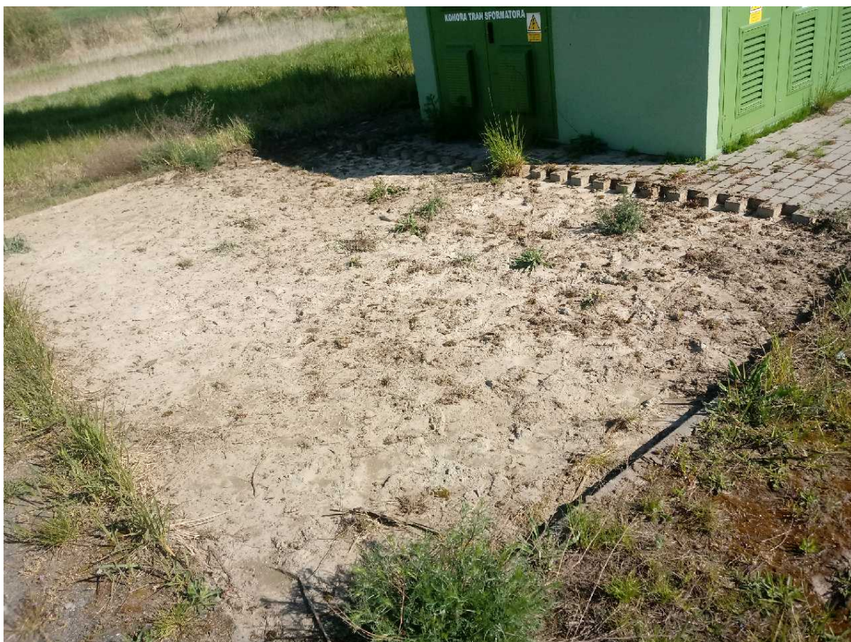
FOT. Nawierzchnia przy jednej z zewnętrznych stacji transformatorowych – do odtworzenia
